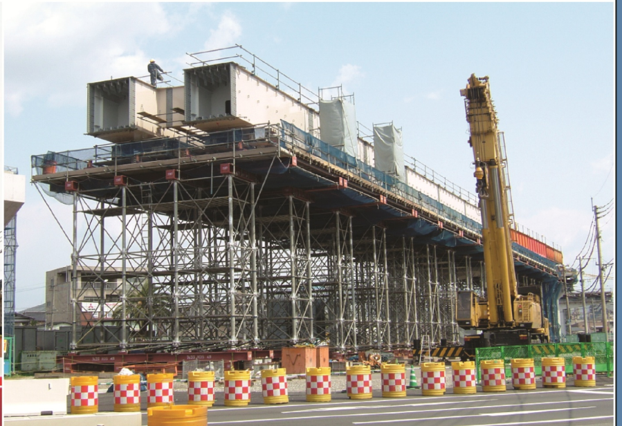
国道3号 黒崎BP 福岡県北九州市八幡西区皇后崎地区 幅員:10m 下床高:8m (押出架設工法)
