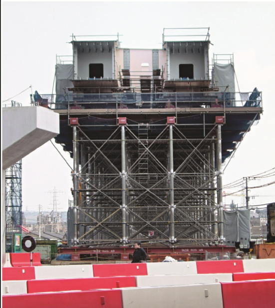
国道3号 黒崎BP 福岡県北九州市八幡西区皇后崎地区 幅員:10m 下床高:8m (押出架設工法)
