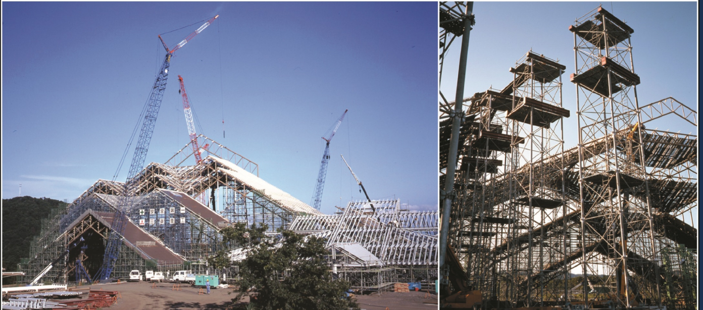
航空機格納庫屋根解体工事 大阪府田尻町泉州空港南地区 受点の高さ:26m
