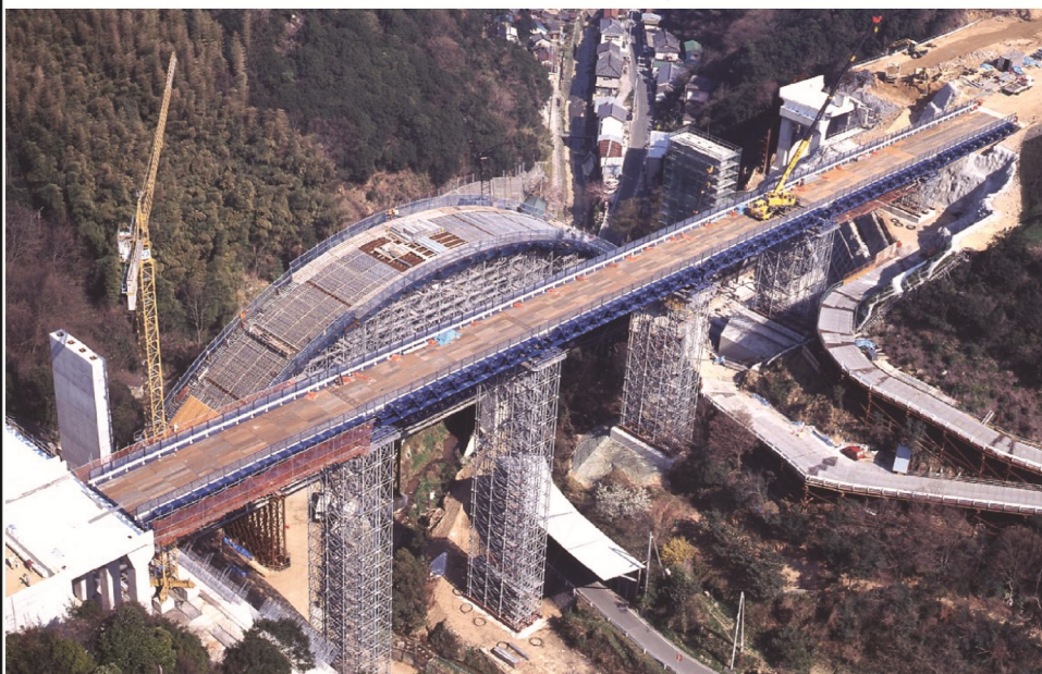
本四架橋淡路ルート 兵庫県淡路市岩屋 茶間川本線橋仮橋 (工事用架設道路 橋長: 180m 高さ: 40m)
