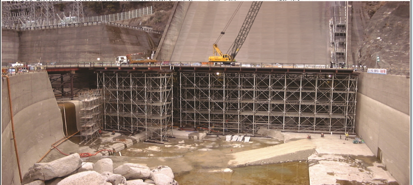
本四架橋淡路ルート 兵庫県淡路市岩屋 茶間川本線橋仮橋 (工事用架設道路 橋長: 180m 高さ: 40m)
