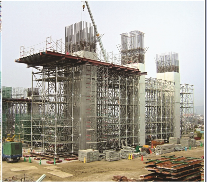
阪神高速道路 7号北神戸線 兵庫県神戸市北区山田町谷上地区 張出し橋脚部の高さ: 30m
