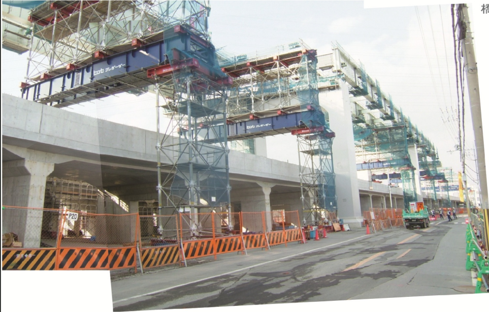
国道3号 黒崎BP 福岡県北九州市八幡西区皇后崎地区 幅員:10m 下床高:8m (押出架設工法)
