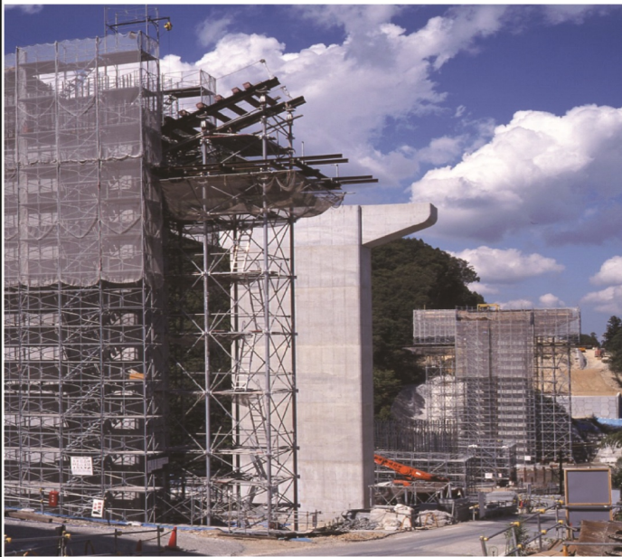
中国横断自動車道 姫路鳥取線 兵庫県相州市矢野町榊地区 ワーゲン柱頭部支保工高: 33m
