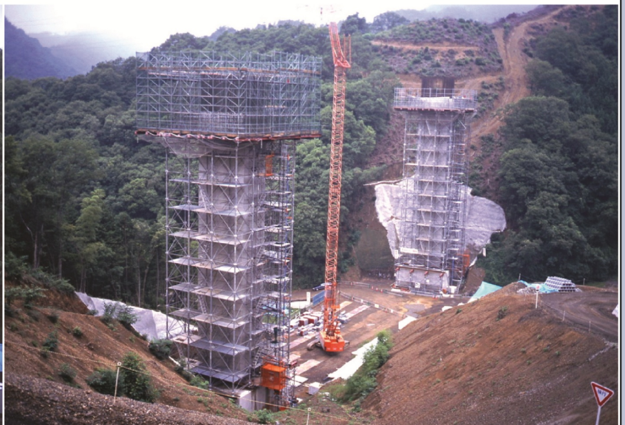
中国横断自動車道 姫路鳥取線 兵庫県相州市矢野町榊地区 ワーゲン柱頭部支保工高: 33m
