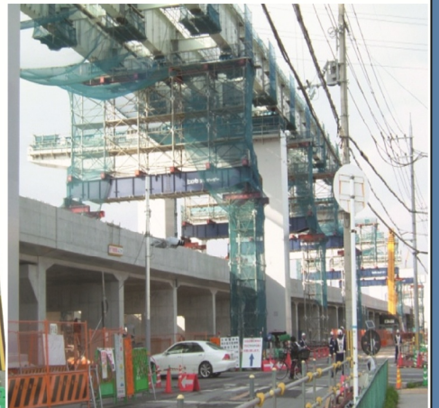
橋軸直角方向は、プレガーター(1B)
