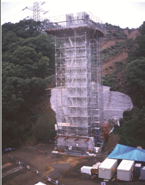
中国横断自動車道 姫路鳥取線 兵庫県相州市矢野町榊地区 ワーゲン柱頭部支保工高: 33m
